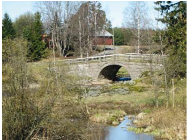
Mannintien holvisilta Liedossa ansaitsi ympäristön raivauksen. Mutta reitiltä löytyy ilahduttaviakin silta-kohteita. Järvenoja, Aura.
