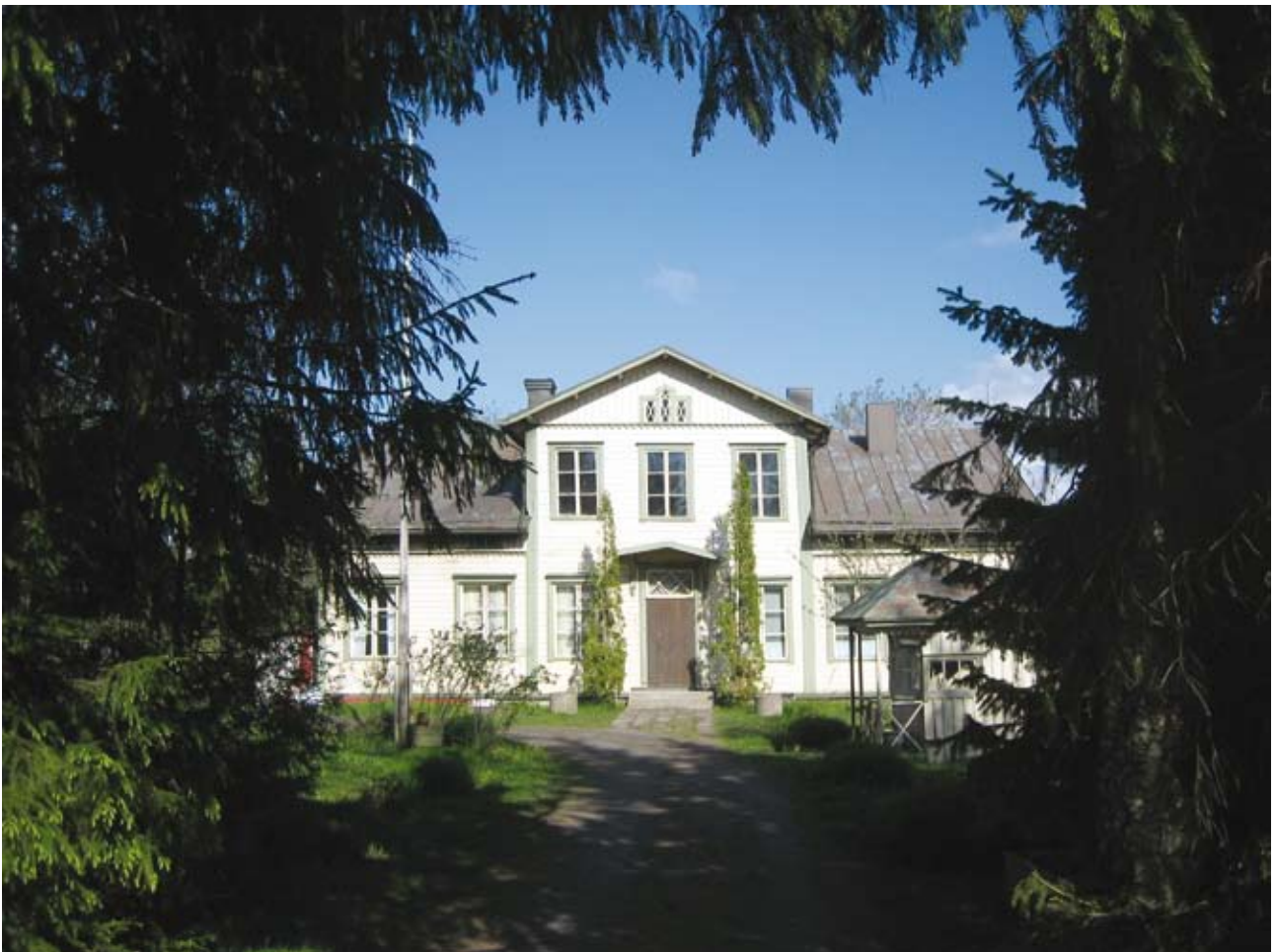
1800-luvun yksityiskohdissa näkyy piirteitä eri tyyli suunnista. Päälinjat juontuvat hirsirakennustekniikasta. Poikkipääty ja yläikkunat viittaavat 1800-luvun loppuun. Väritys on ajan henkinen. Koskenpää, Viilala, Aura.
