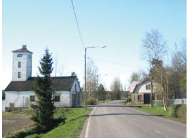
Paloasema ja Gyldenin paja: tiellä liikkujan portti. Katso niitä uusin silmin - hienoa arkiarkkitehtuuria, säilyttämisen arvoista. Mäkiäinen, Pöytyä.
